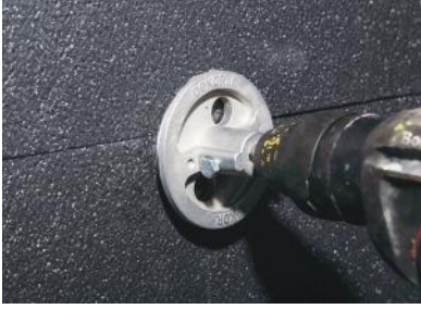
Şekil 1 Duvar özelliğine göre seçilmesi gereken dübelin başlığının tam olarak yerleştirilmesi ve kalınlık oluşturmaması için aparat kullanılarak havşa başının açılması gereklidir.
