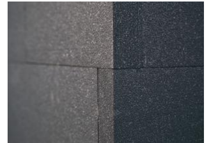
Şekil 3 Isı yalıtım levhaları, duvarın alt kısmından başlanarak yukarı doğru aralıksız ve şaşırtmalı olarak döşenir. Köşelerde de levhalar şaşırtmalı olarak yerleştirilmelidir.
