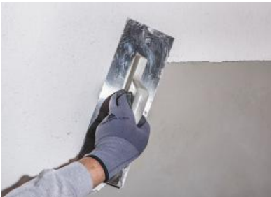
Şekil 1 Teknosistem Mineral Dokulu Dekoratif Sıva, malayla yüzeye uygulanır
