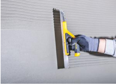
Şekil 1 Teknosistem ısı yalıtım levhalarının yapıştırılması ve dübellenmesi işlemlerinden sonra ilk kat yüzey sıvası uygulaması yapılır. Hazırlanan Teknosistem sıva harcı, çelik mala yardımıyla yüzeye eşit miktarda homojen olarak uygulanır. Yüzey sıvasının uygulama kalınlığı her bir katta en fazla 2 mm olmalıdır.
