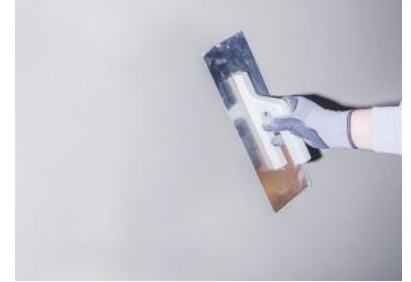
Şekil 3 Hava durumuna bağlı olarak ilk kat sıva harcının hafifçe suyunu atması beklenerek ikinci kat sıva harcı uygulaması tamamlanır.
