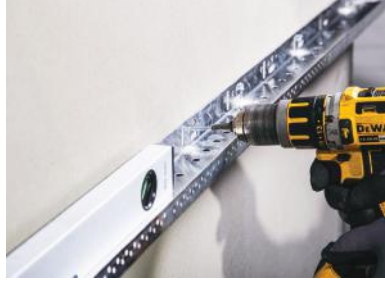
Şekil 2 Yüzey gönyeye alındıktan sonra Teknosistem Subasman Profili dübelle monte edilir.
