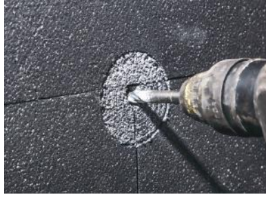
Şekil 2 Dübel yeri matkapla delinir. Delik boyu, dübel boyundan 1 cm büyük açılmalıdır.
