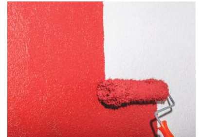
Şekil 3 Son olarak dış cephe astar ve boya uygulaması yapılır.
