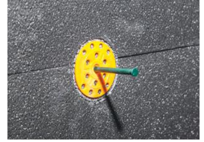
Şekil 3 Açılan dübel deliğine dübeller yerleştirilerek dübel çivileri tamamen çakılır.
