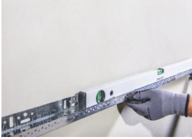
Şekil 1 Teknosistem Subasman Profili Montajı, mantolama sisteminin dengeli ve düzgün olmasını sağlar. Yüzeyde olası eğrilikleri düzeltmek için duvar ile subasman profili arasındaki boşluklar, girintiler ve çıkıntılar farklı kalınlıklardaki takozlarla düzeltilerek yüzey gönyeye alınır.
